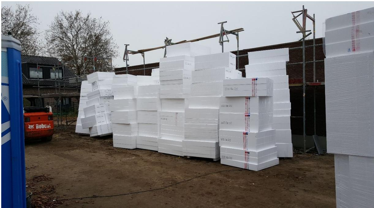
Anlieferung der Dachdämmung als Gefälledämmung
