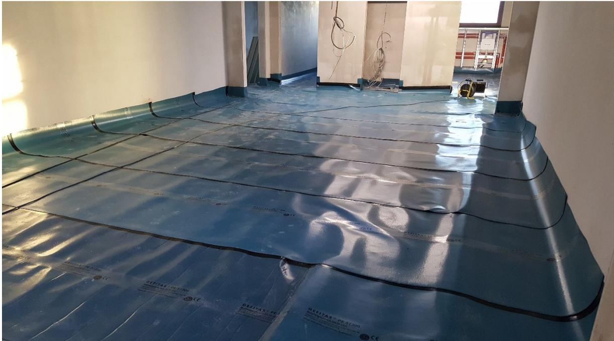
Dampfsperre in fertig verputzten Räumen als Vorbereitung für die Fußbodenheizung
