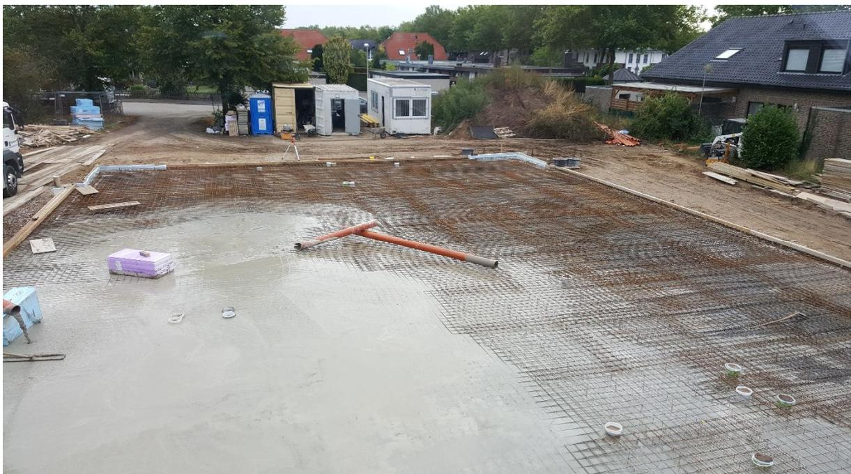
Betonieren der Bodenplatte
