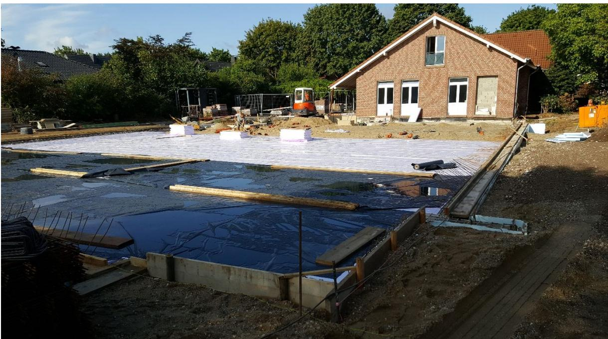
Perimeterdämmung unterhalb der Bodenplatte
