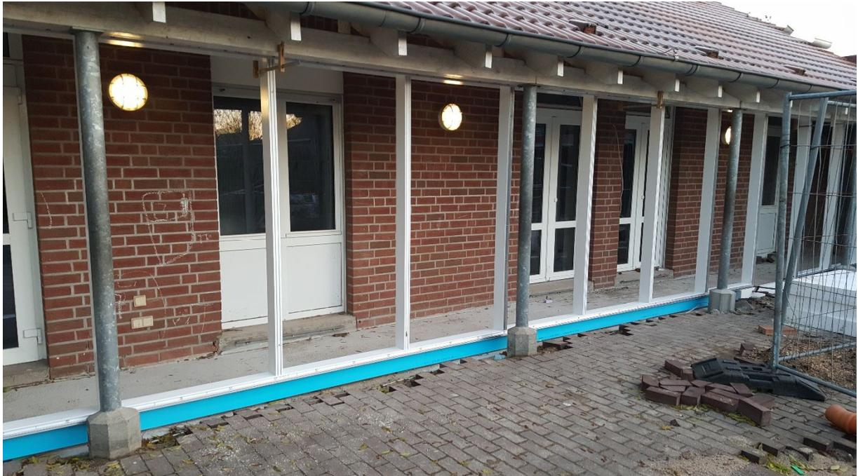
Pfosten-/Riegelkonstruktion neuer Verbindungsgang (ohne Glas)
