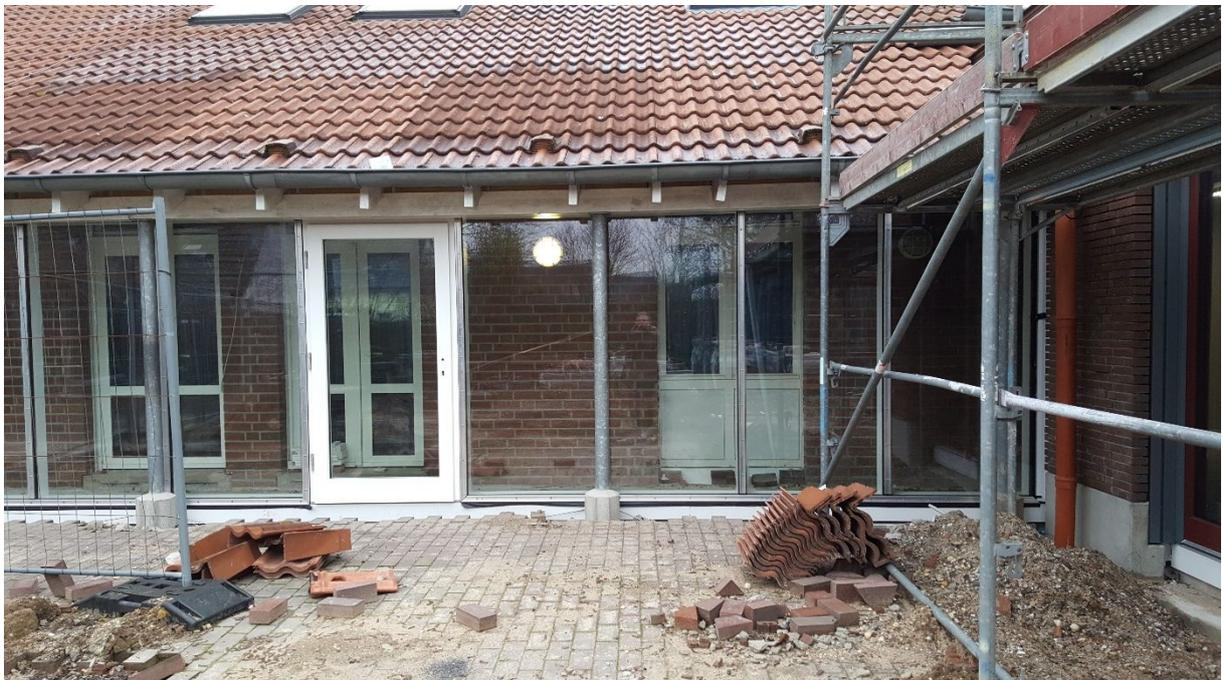
Pfosten-Riegelkonstruktion mit Ausgangstür und Verglasung
