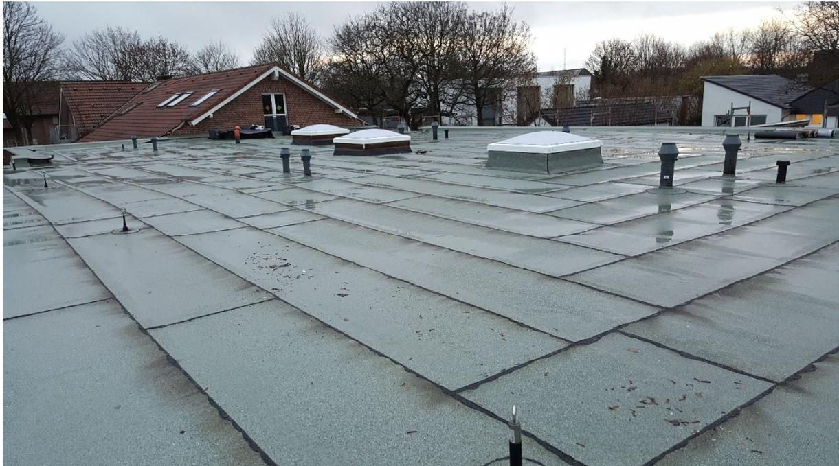
Flachdach mit Lichtkuppeln, Sekuranten und Lüftungshauben
