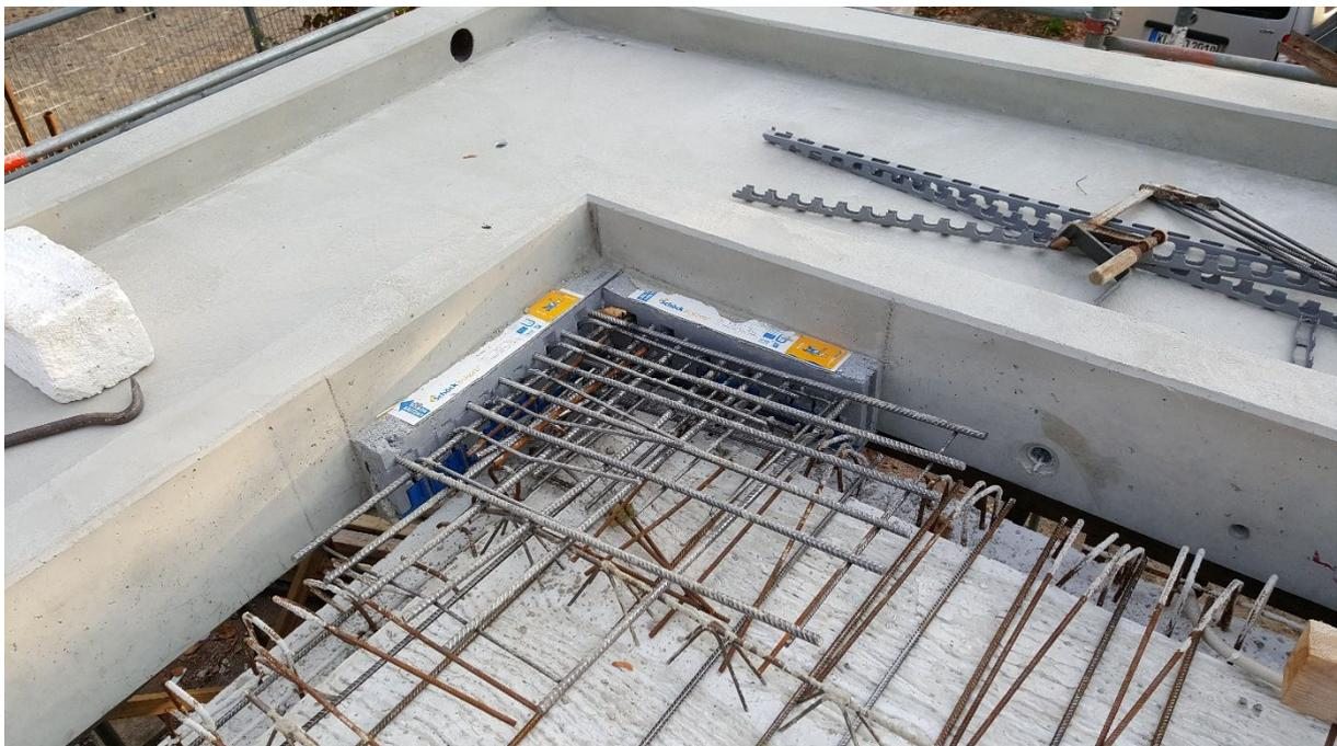
Montage Fertigteile Außenecken mit Schöck-Isokorb
