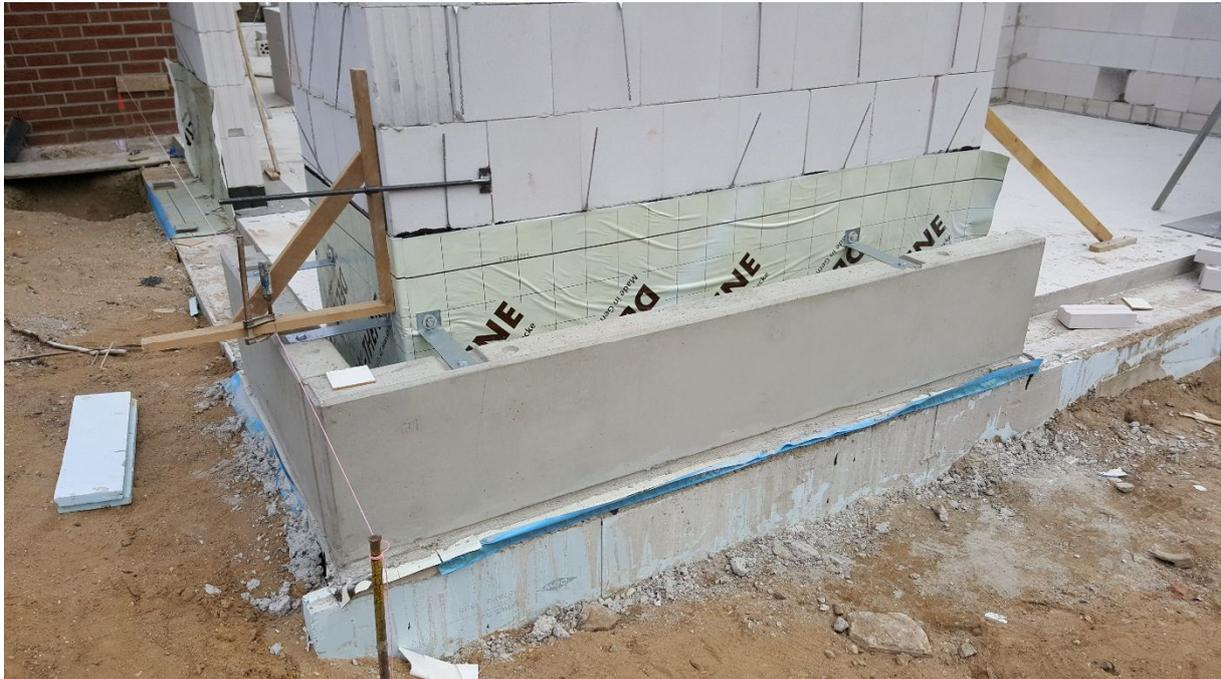
Montage Betonsockel als Fertigteile
