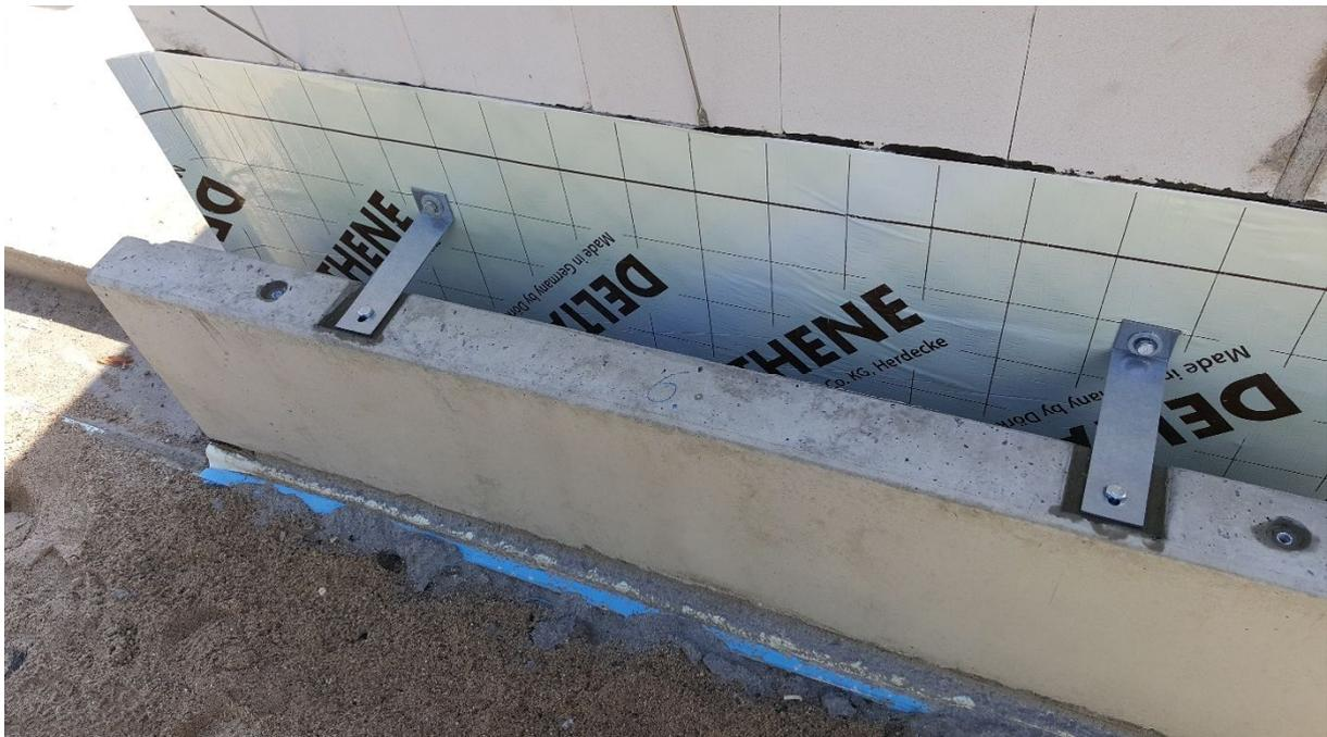
Verankerung Betonsockel / Sockelabdichtung
